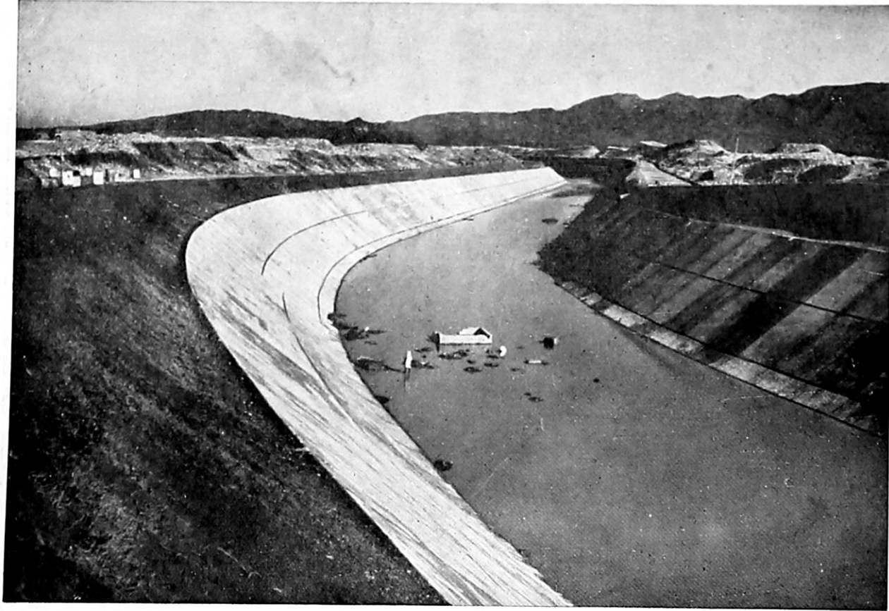
नांगल पत-बिजली नहर का एक खंड—भाखरा नांगल बाँध प्रकल्प
