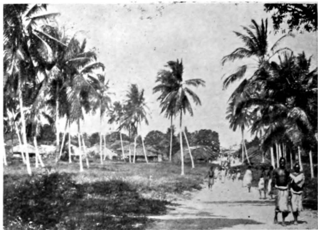
ROAD IN BAGAMOYO.
