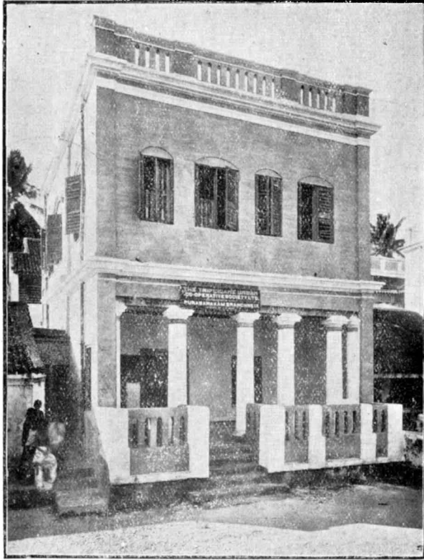
T. U. C. S. PREMISES :—PURASAWALKAM BRANCH.
