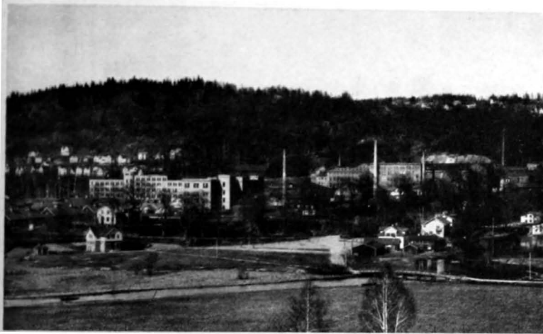
The Huskvarna Factories (Husqvarna Vapenfabriks A.-B.).
